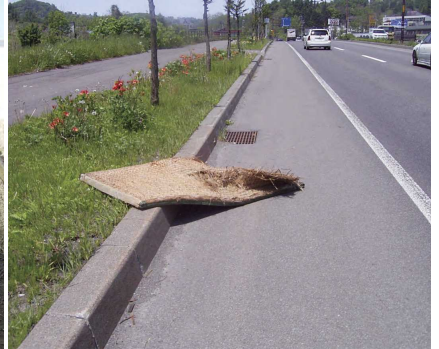
路面の落下物
