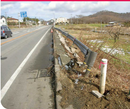
ガードレール・標識等の損傷
